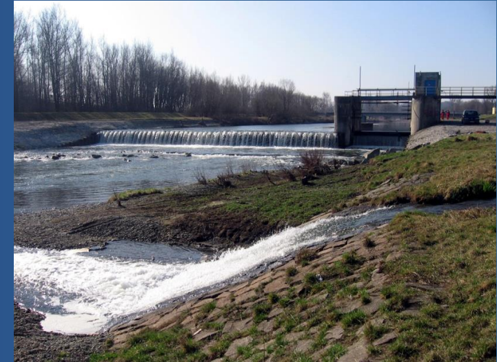
Současný pevný jez na řece Olši v Dětmarovicích
