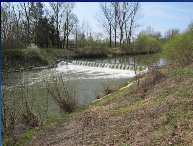
Spádový stupeň na Odře určený ke zprůchodnění
